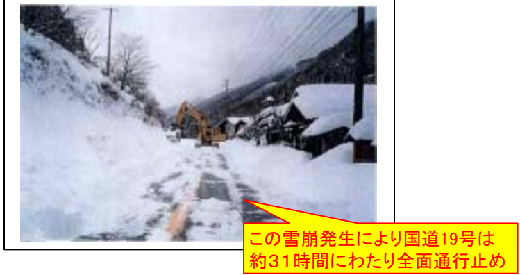
H10.1.15 大雪による雪崩発生状況
